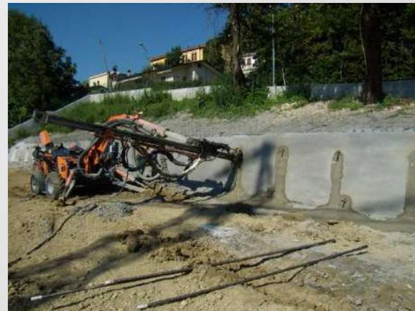
FOTO 4 - Perforazione con iniezione in avanzamento
