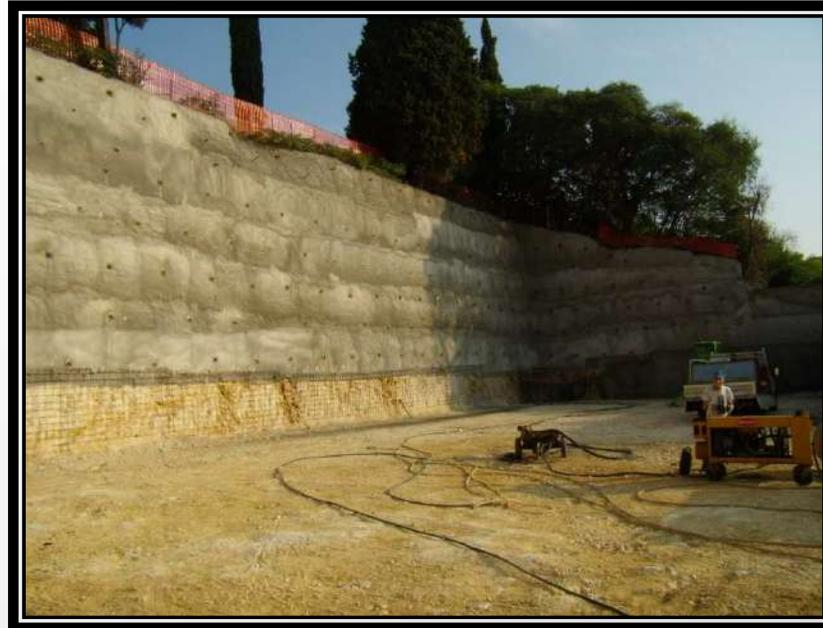
La densità di chiodi può variare da 1,5 m/mq a 3-4 m/mq a seconda del tipo di terreno. Per densità maggiori risulta conveniente una berlinese tirantata. Solitamente il passo orizzontale va da 1,5 a 3 m e quello verticale da 1 a 1,5 m a seconda del grado di autosostentamento del terreno nella fase di scavo
